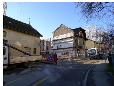
Le chemin du Pont-de-Ville
