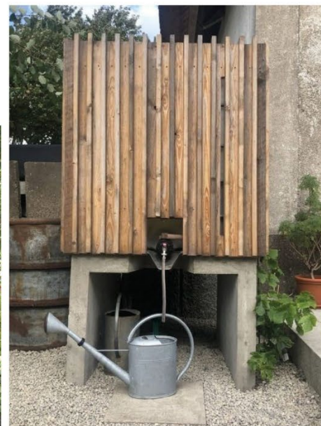
la citerne d'eau de pluie
