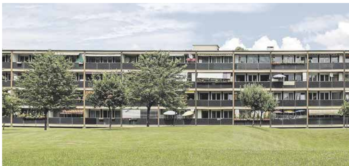
Immeuble d'habitation réalisé en 1960 par les architectes Jean-Marc Lamunière, Pierre Borsa et Jacques Nobile, situé avenue A.-M.-Mirany 37, photographie Giuliana Merlo (©office du patrimoine et des sites).
