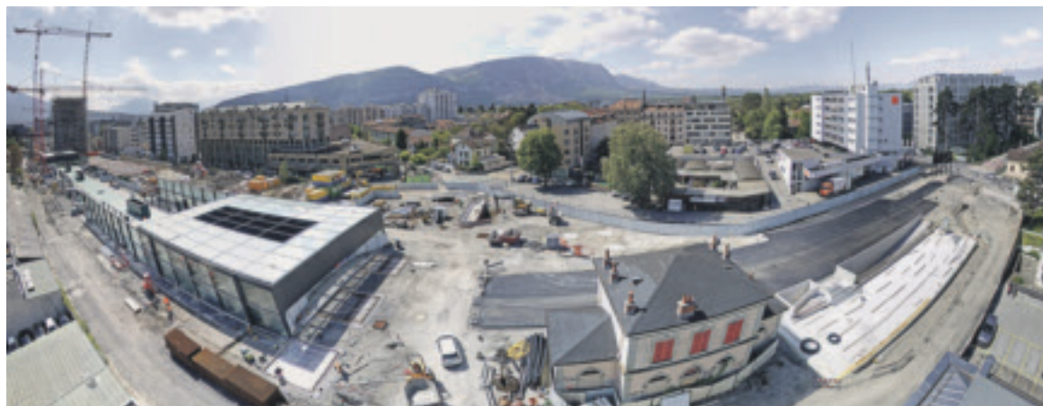
Vue aérienne des chantiers du périmètre de la future gare du Léman Express et de la Tour Opale.
