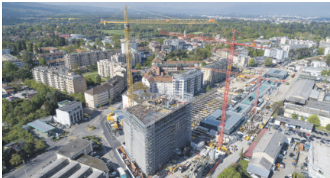
Vue aérienne Chantier Interface.
