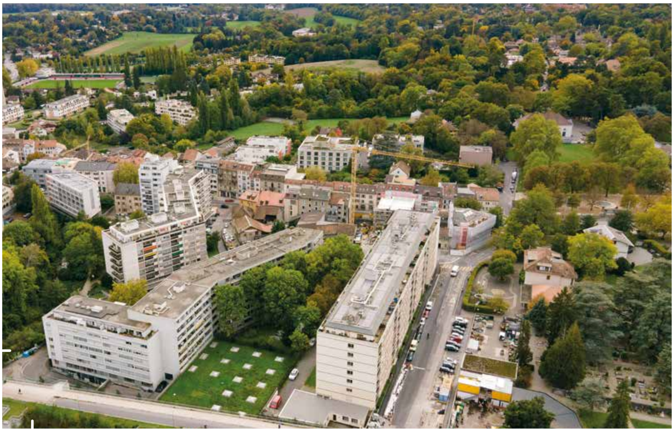
Chemin du Pont-de-Ville - Le chantier du Village
