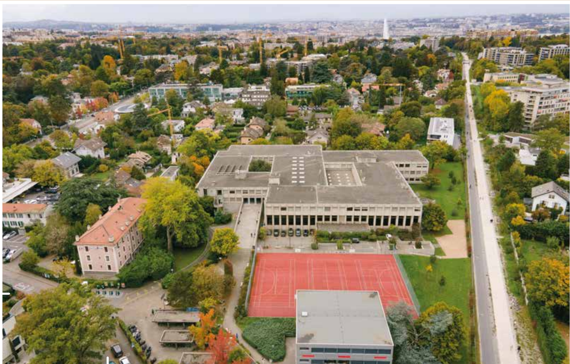
Grange-Falquet - École de culture générale Jean-Piaget - Voie verte
